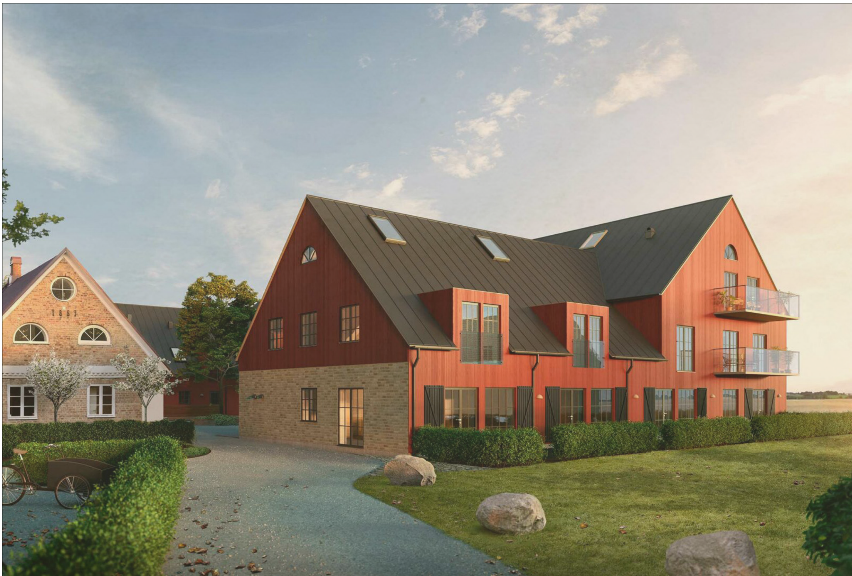
Nöbbe gård i Nöbbelöv, Lund. 21 lägenheter som just nu håller på att byggas.
