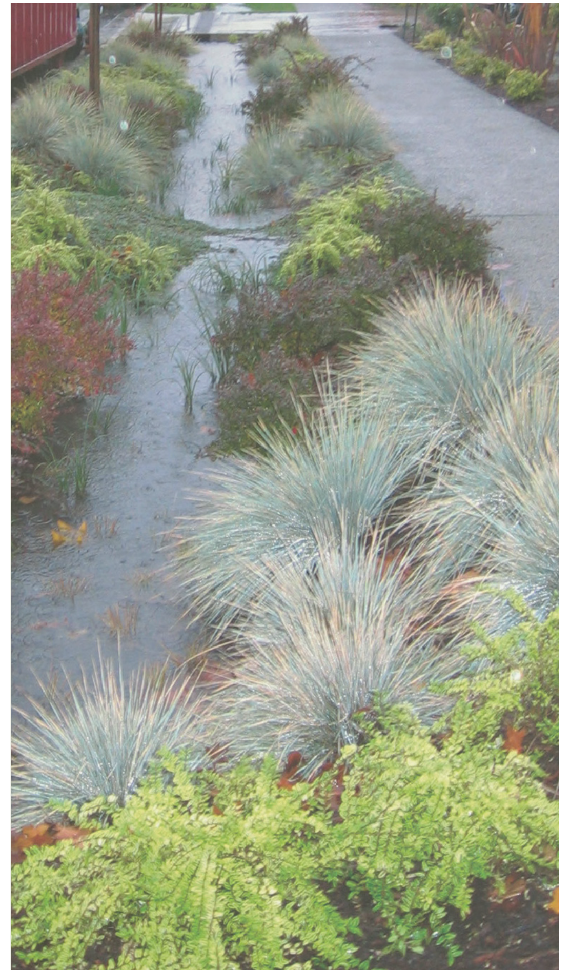
Det är både vackert och effektivt med öppna fördröjningsmagasin.
